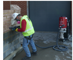
FOTO CORTESÍA DEL INSTITUTO INTERNACIONAL DE ALBAÑILERÍA
